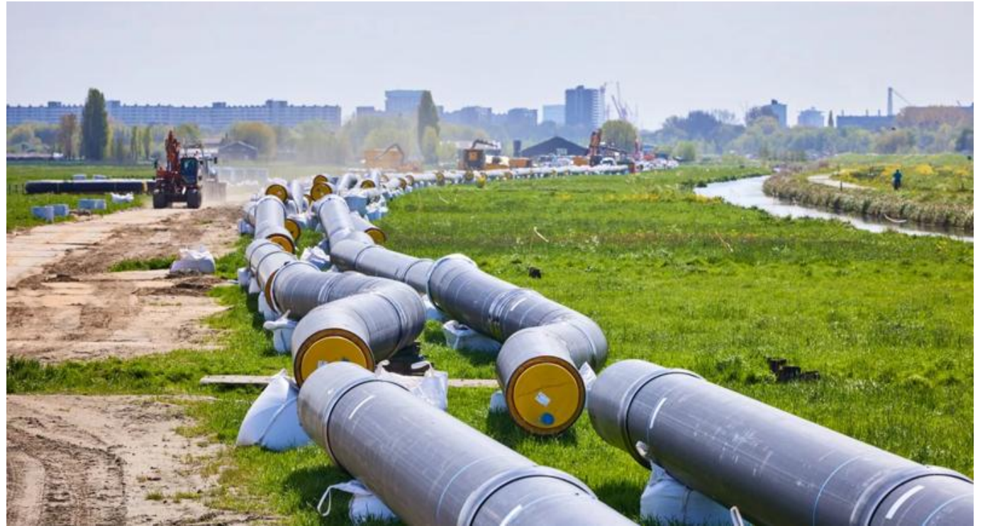
Warmteleidingen in aanleg
