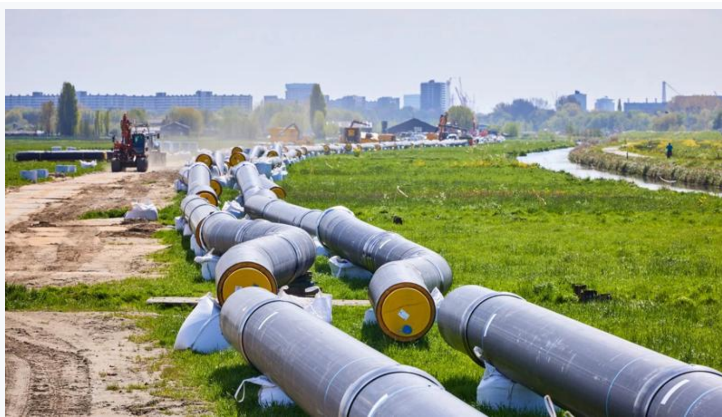
Warmteleidingen in aanleg
