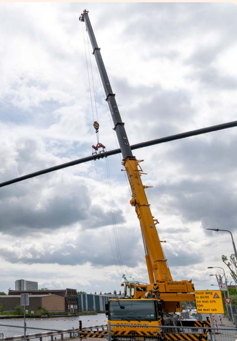
Hijskranen takelen een warmtebuis over de Schie
